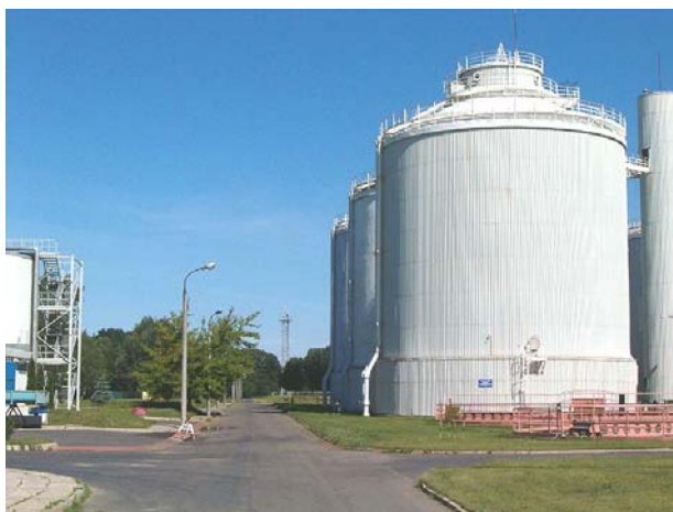
Fotografia 4: Komory fermentacyjne, w tle pochodnia.
